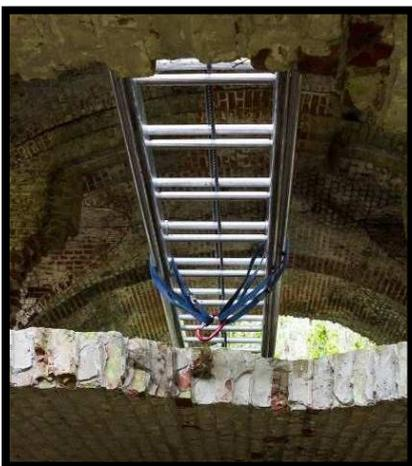
Il est possible d'utiliser une échelle à mains pour disposer d'un point d'ancrage en surplomb.
