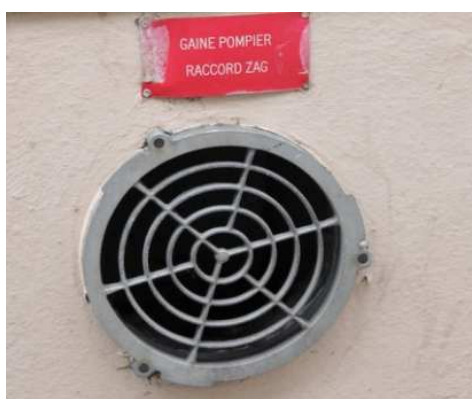
Illustration n°1 : Un raccord « ZAG » en façade
