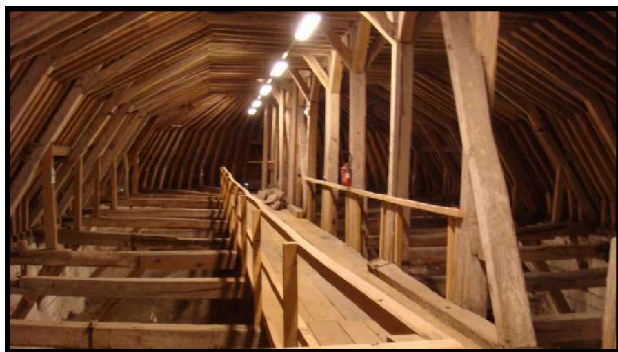
Charpente Cathédrale de Beauvais
