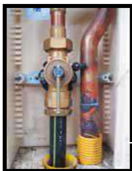
Robinet de pied de colonne montante
