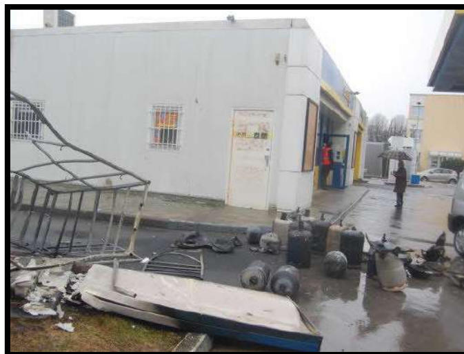
Incendie stockage bouteille de gaz dans le Finistère
