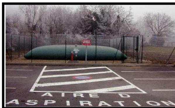
Bâche de 120 M3
