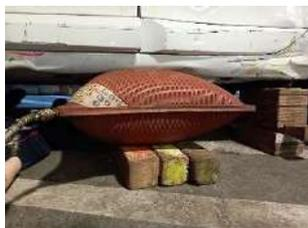
Les coussins de levage vont servir principalement pour dégager une victime bloquée sous un véhicule.
