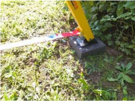
L'étai doit être posé sur un sol offrant une résistance convenable (exemple: bitume). Si cela n'est pas le cas, placer la semelle sur une cale ou un bastaing afin d'augmenter la surface de contact.
