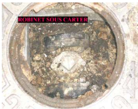
Organe de coupure générale sous carter © GRDF
