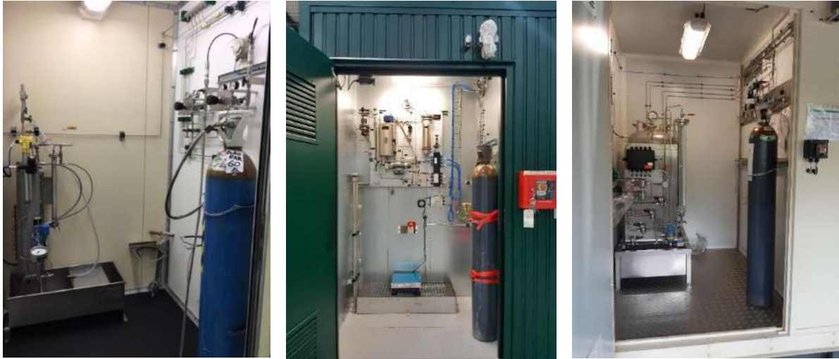
Différents types de postes d'injection de THT © GRDF
