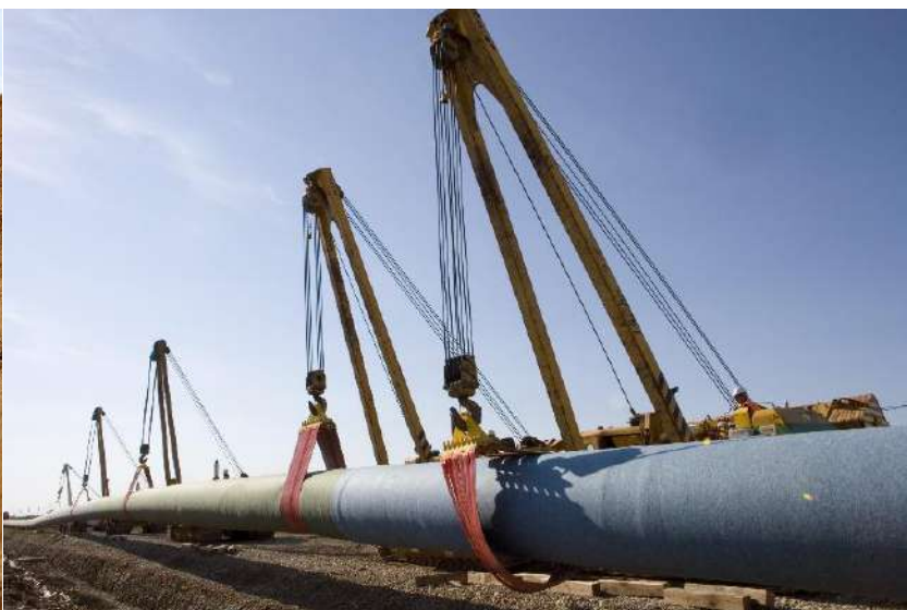
Pose du gazoduc Val-de-Saône et Fos Cavaou © GRTgaz
