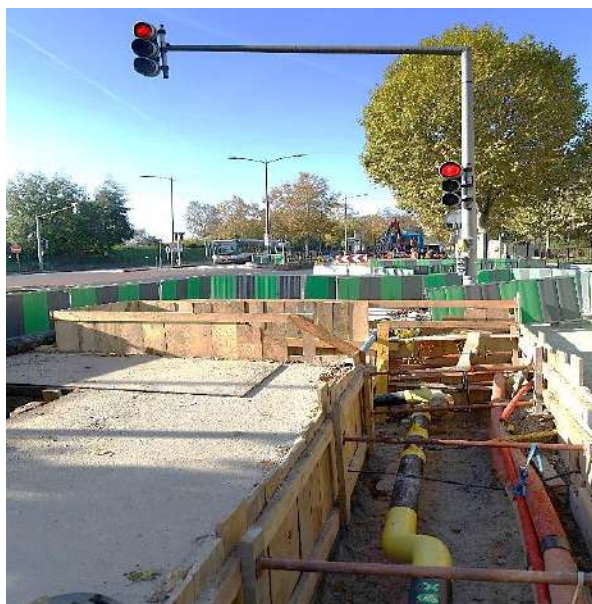
Canalisation à périmètre de sécurité étendu et poste de détente réseau MPC/MPB © GRDF
