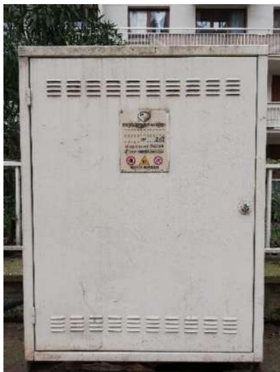
Poste GRDF de livraison gaz RESEAU , les sapeurs-pompiers ne peuvent pas couper le gaz, il n'y a pas d'organe de coupure générale. © Christophe Perdrisot – DGSCGC
