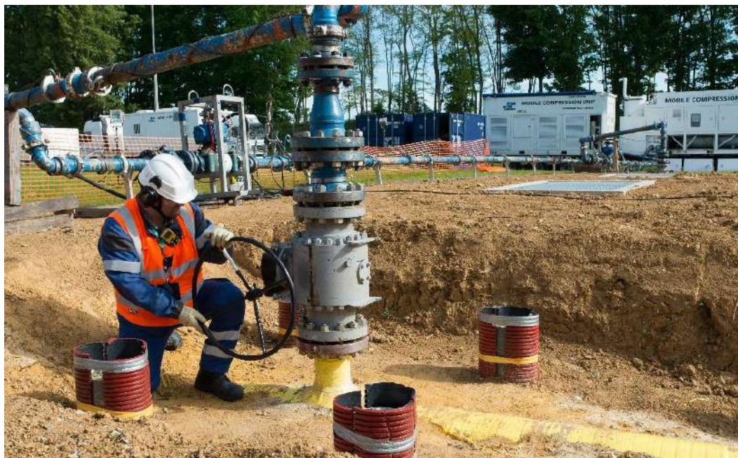
Opération de gas booster en Seine-et-Marne © GRTgaz
