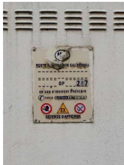
Poste GRDF de livraison gaz RESEAU , les sapeurs-pompiers ne peuvent pas couper le gaz, il n'y a pas d'organe de coupure générale. © Christophe Perdrisot – DGSCGC
