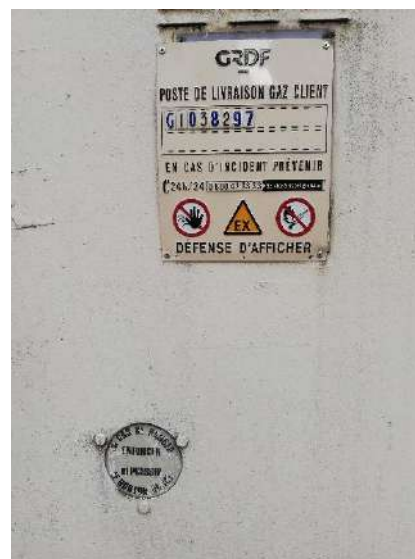
Poste GRDF de livraison gaz CLIENT , les sapeurs-pompiers peuvent couper le gaz, il y a un organe de coupure générale accessible depuis la voie publique. © Christophe Perdrisot – DGSCGC
