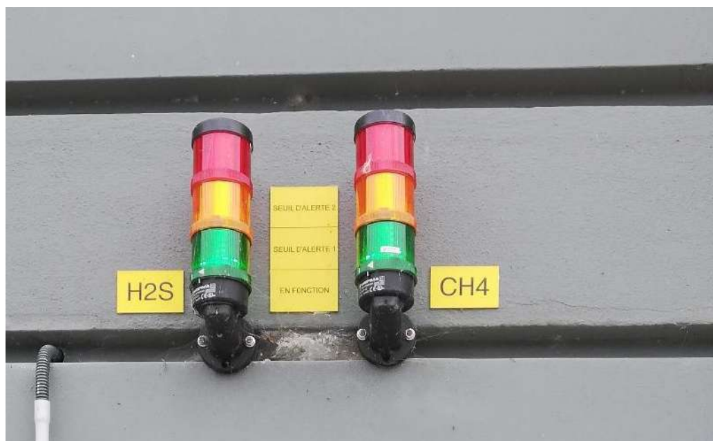
Voyants lumineux des seuils d'alerte (H 2 S et CH 4 ) situés à l'extérieur d'une station d'assainissement © Christophe Perdrisot - DGSCGC
