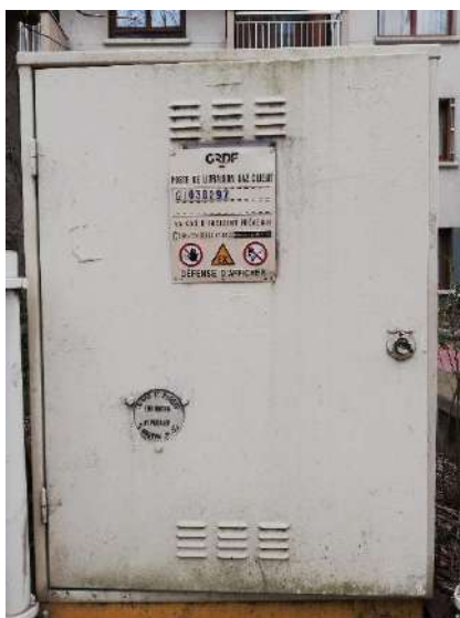
Poste GRDF de livraison gaz CLIENT , les sapeurs-pompiers peuvent couper le gaz, il y a un organe de coupure générale accessible depuis la voie publique. © Christophe Perdrisot – DGSCGC
