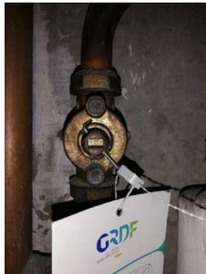
L'indicateur perpendiculaire à l'axe de la conduite signale que le robinet est fermé.
